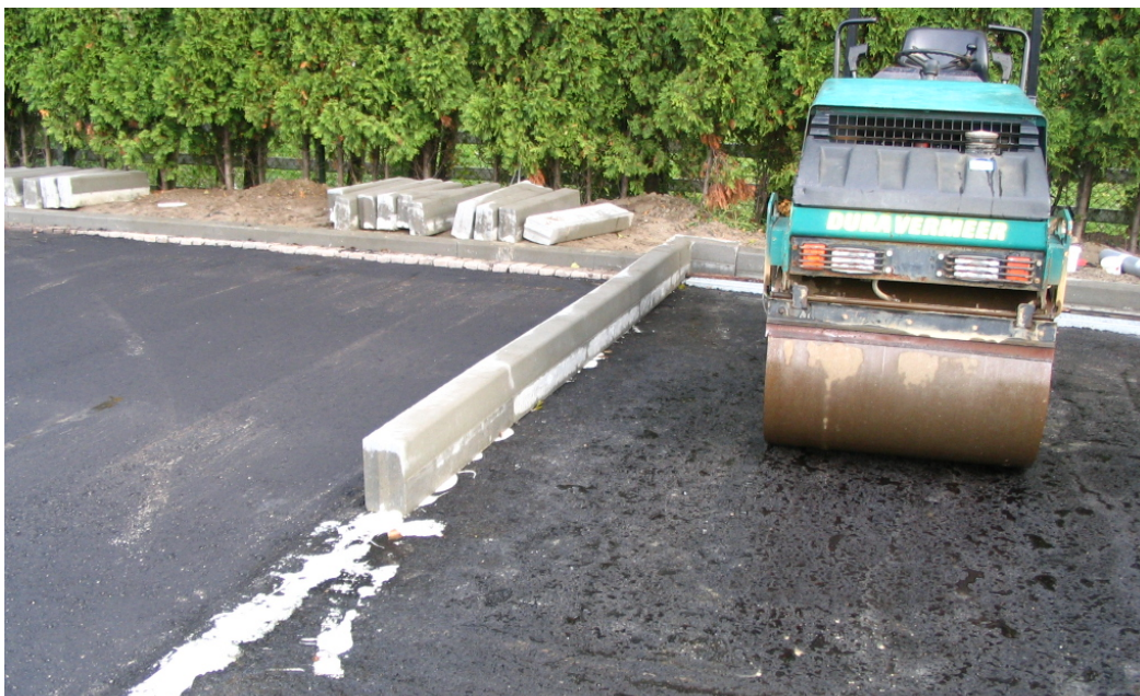
Foto: Verdichten van het asfalt
